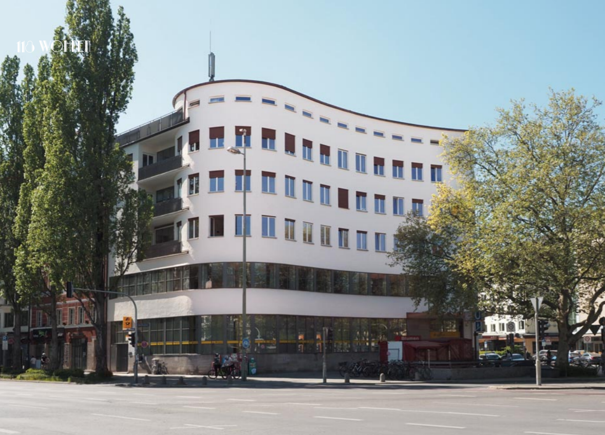
Selbst Zweckbauten gaben sich avantgardistisch. Der fast vergessene Architekt Robert Vorhoefer gestaltete innovative Fassaden wie die geschwungene Post am Goetheplatz. ©Ruben Kabalo
